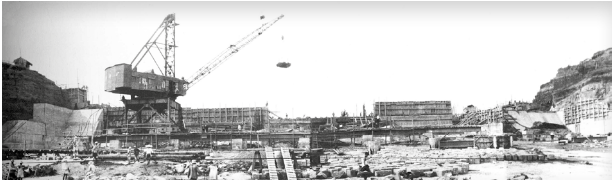
Фото 4. Строительство ГЭС Сыцзытань. РГА в г. Самаре. Ф. Р-1016. Оп. 1. Д. 17. Л. 7
