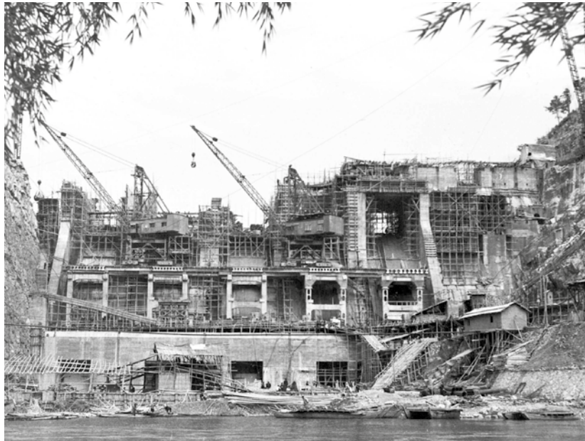
Фото 3. Строительство ГЭС Шанюй. РГА в г. Самаре. Ф. Р-1016. Оп. 1. Д. 17. Л. 11
